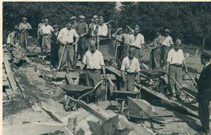
Pomagają przy budowie żołnierze LWP
