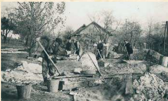
Robotnicy przy pracy
